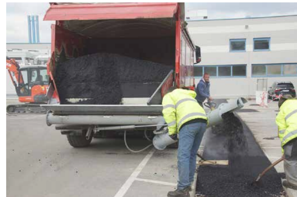
Fertigerbetrieb mit Zentrierbleche, reduziert thermische und mechanische Entmischung/Segregation
