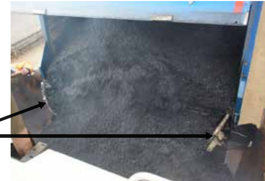
Fertigerbetrieb mit Zentrierbleche, reduziert thermische und mechanische Entmischung/Segregation
