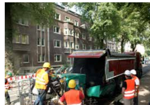
BV Duisburg Asphaltieren in der Innenstadt mit vielen Hindernissen.
