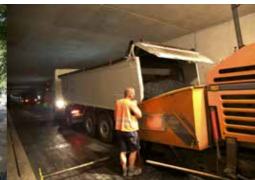
Autobahnstück A66 bei Fulda 4 Fahrspuren mit temperaturabgesenkten Asphalt.
