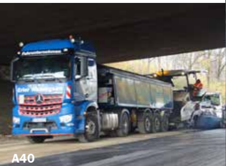
Nachher: Kontinuierlicher Asphaltteinbau ohne Stop and Go selbst bei Hindernissen und Bauwerken...
