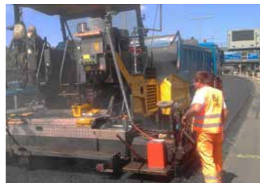
Autobahn A 100 in Berlin, meistbefahrenste Straße Europas Einbau von Porous Mastix Asphalt (PMA)
