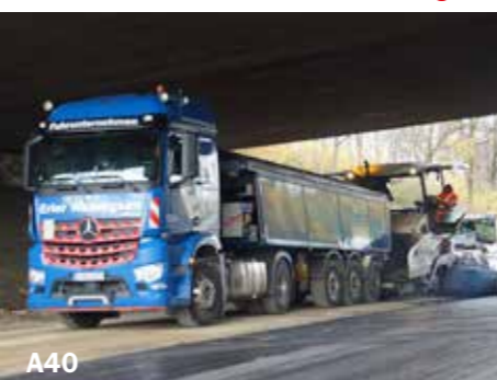
Nachher: Kontinuierlicher Asphaltteinbau ohne Stop and Go selbst bei Hindernissen und Bauwerken...
