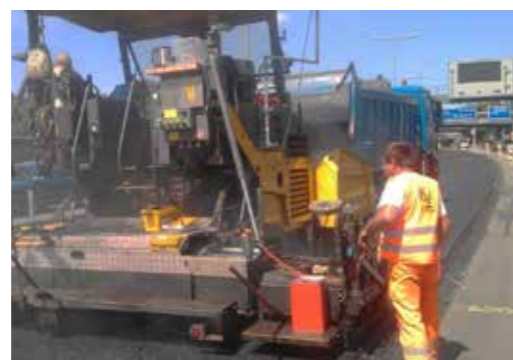
Autobahn A 100 in Berlin, meistbefahrenste Straße Europas Einbau von Porous Mastix Asphalt (PMA)
