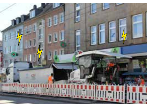
Baustelle in Essen Auf einer Strecke von ca. 800 m, über 80 Einbauten sowie Oberleitungen
