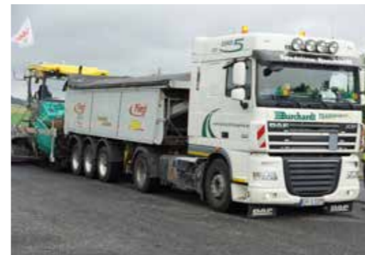
BV Autobahn A2 Nähe Hannover Einbau von OPA (PA) – ASS 372 Einsatz von 23 Fahrzeugen.
