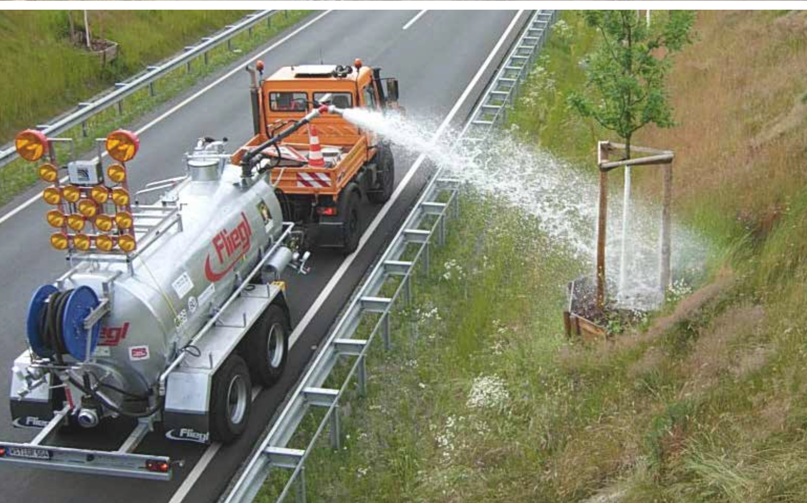
Wasserrass mit Schlauchhaspel und Regnerdüse
